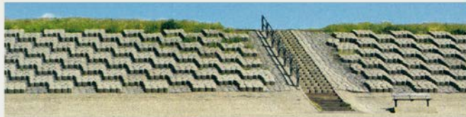
De Hondsbossche zeekering met 'betonzullen' in Noord-Holland
